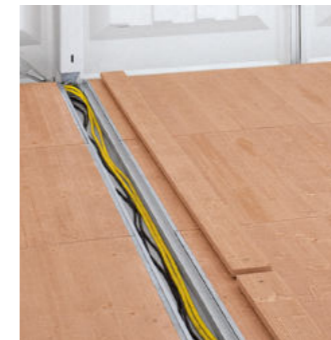
System-Kassettenfußboden mit integriertem Kabelkanal und variabel positionierbarem Leitungsaustritt
