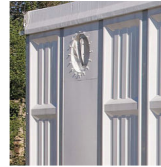
Systemwandelemente aus Kunststoff mit Anschlusskassette für Einsatz von Heizungs- und Klimageräten
