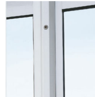
Wandhalteschiene mit versenkter Arretierung für Systemwandelemente aus Glas (Wandverriegelungsschiene)
