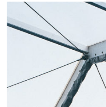
Riegelrinne zur Riegelstoßabdichtung (ab 25 m Spannweite)
